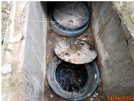
บ่อพักก่อนเข้าสู่ระบบบำบัดน้ำเสียของอาคารที่พักผู้โดยสาร
